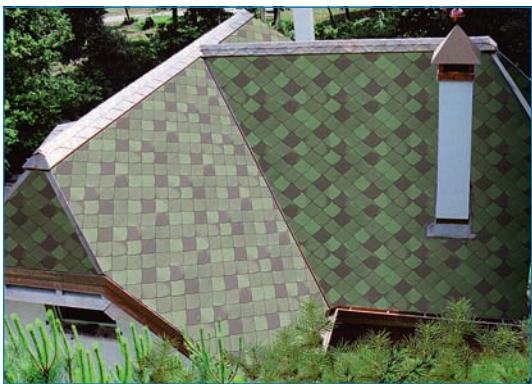
При укладке черепицы на скатах при уклоне больше  $60^{\circ}$  лист должен крепиться 6 гвоздями (2 дополнительных гвоздя фиксируют верхние углы листа на расстоянии от краев 2,5 см).
